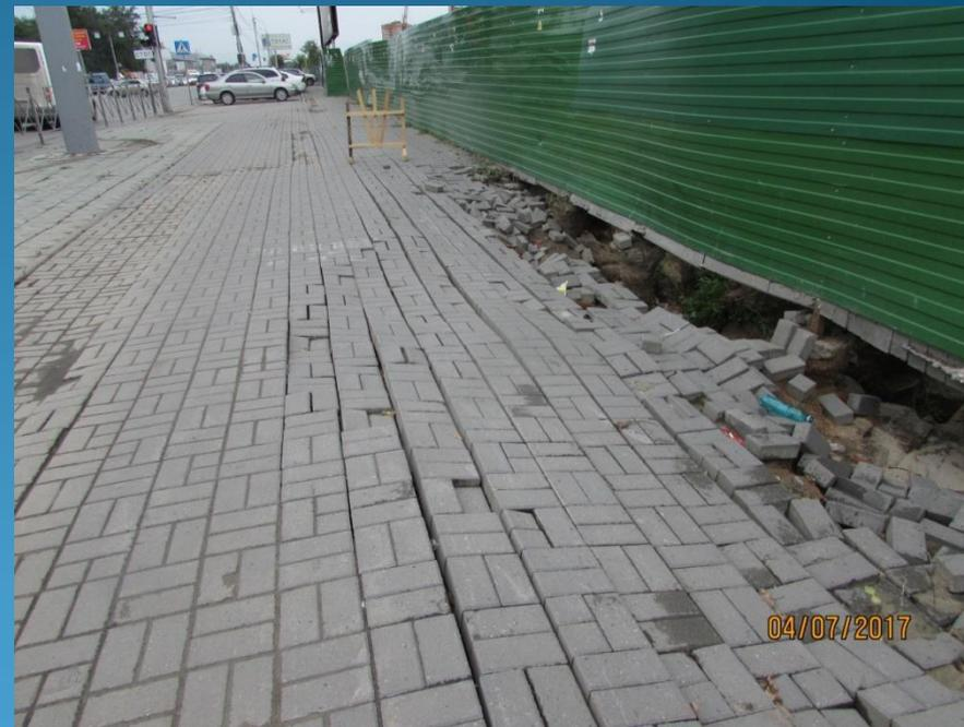
На восстановленном в июне месяце тротуаре в зоне расположения строящегося комплекса зафиксирована трещина протяженностью до 20 метров с раскрытием более 5 см, глубиной более 20 см, провалы грунта и тротуарной плитки вдоль ограждения строительной площадки.
